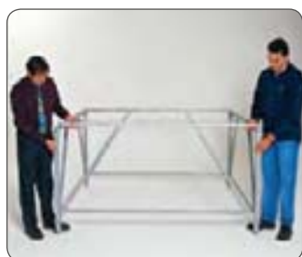
2 - Ensamblaje del marco y postes para formar los módulos de 2 x 2 m. Ajuste de las roscas.
